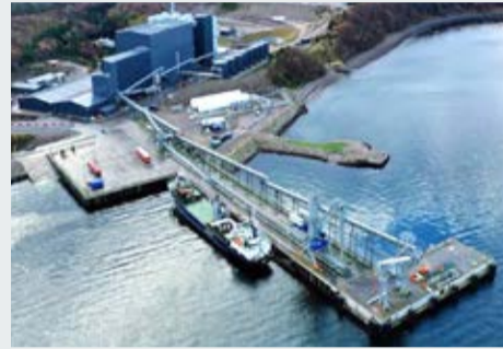
Mini LNG Terminal
